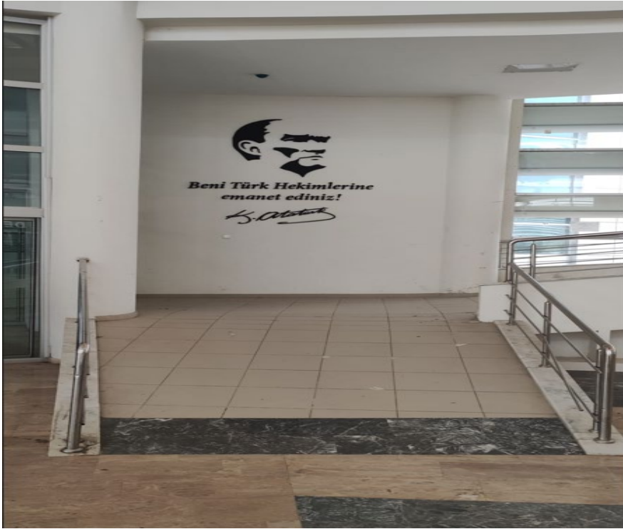
Fotoğraf TS 7.1.7./2. Dekanlık Binası Engelli Rampası
