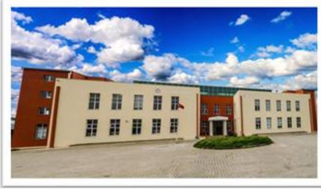
Hemşirelik Fakültesi Binası
