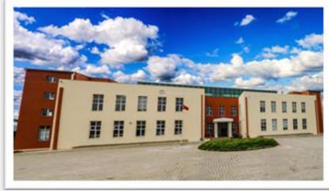
Hemşirelik Fakültesi Binası
